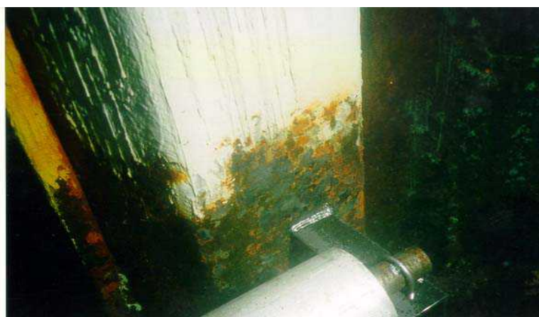
Figure 1 : Port d'Ajaccio - Quai de la Chambre de Commerce - Système duplex : revêtement et protection cathodique
