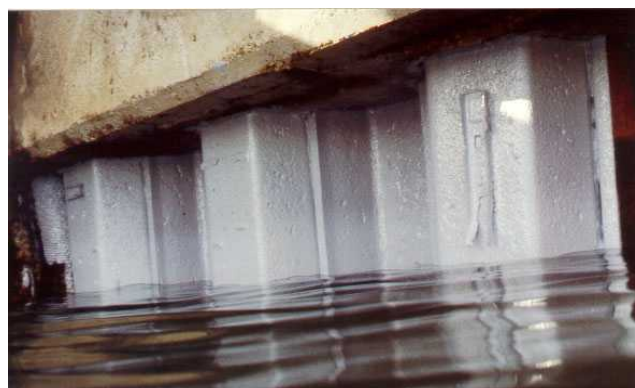
Figure 4 : Ajaccio Quai CC - Revêtement appliqué en 2 couches
