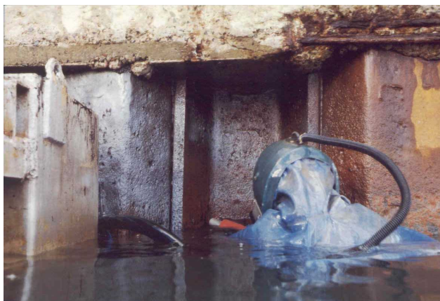
Figure 2 : Ajaccio Quai CC - Sablage zone d'éclaboussures
